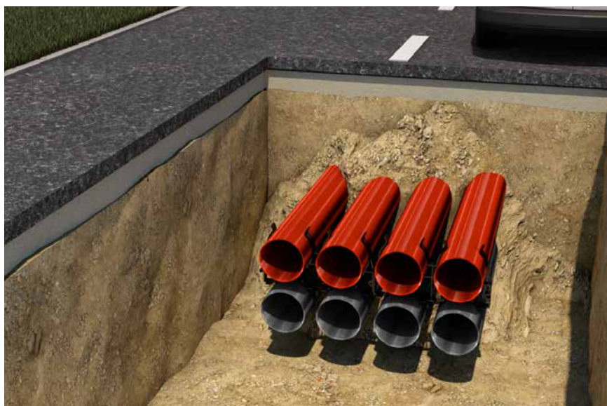
Minimale Verlegetiefe von Kabelschutzschläuchen bei Schwerlastverkehr SLW60
