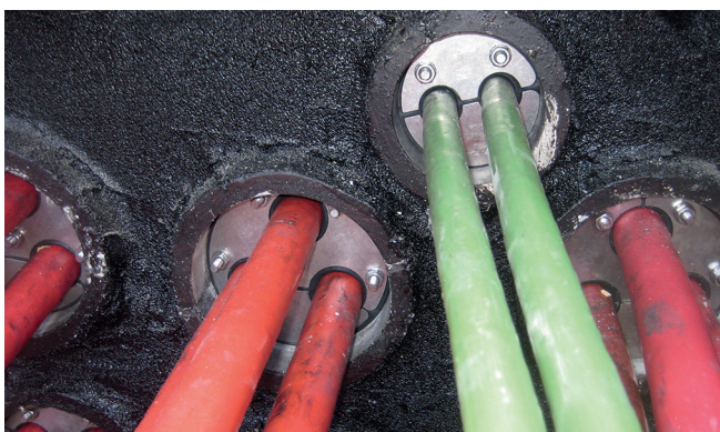
Sve kabele se naknadno brtve u proturne cijevi razdijeljenim prstenastim brtvama izrađenima po mjeri.
