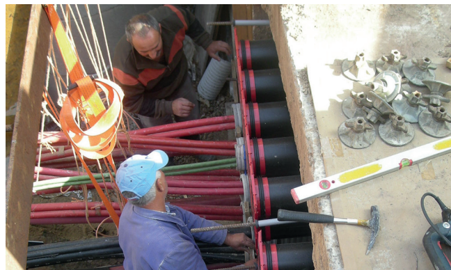
Ugradnja zidnih uvodnica HSI 150-K2 i razdijeljene proturne cijevi FZR-G.
