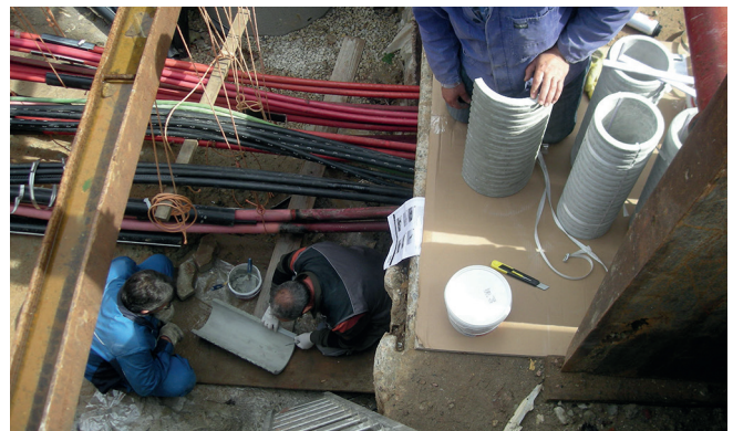
Ugradnja razdijeljene cijevi od vlaknastog cementa FZR-G.
